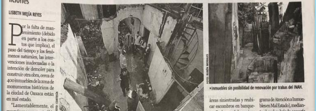
Muchas construcciones del Centro Histórico están a un paso de quedar en ruinas.
